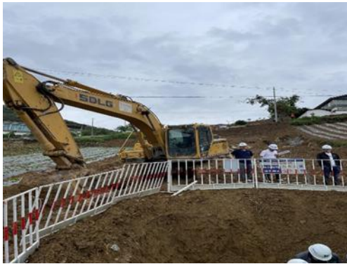
斜坡地段及沟槽未设置人员 上下通道
