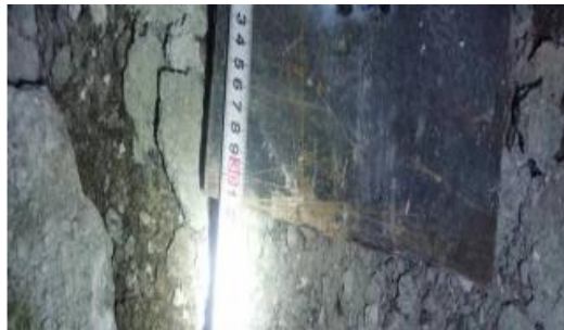
三坝水库钢支撑垫板尺寸现场测量
