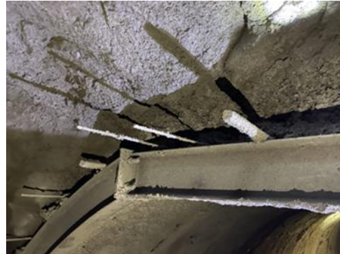
钢筋网未预留搭接长度
