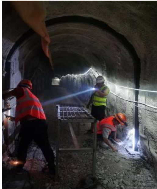
三坝水库导流输水隧洞加装钢支撑施工现场图像
