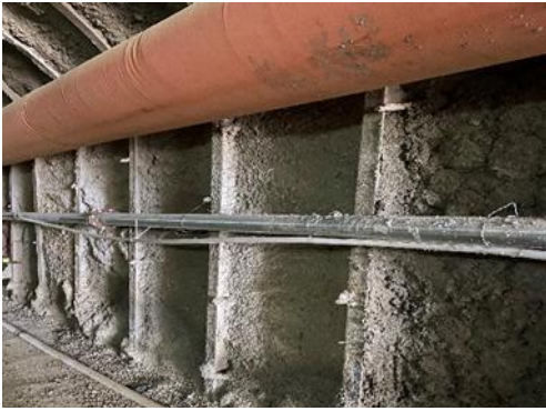
边墙喷混凝土喷层
