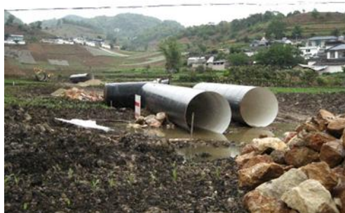
叠水大沟输水管 DS23+520 ~ DS23+650 段埋管现场
