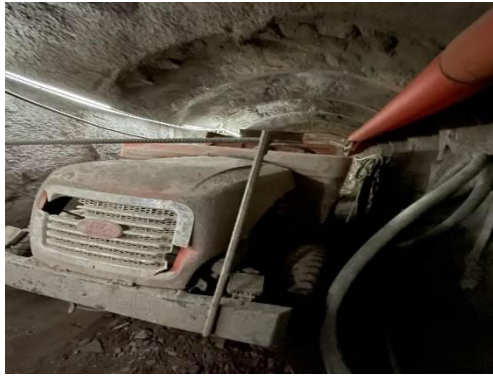
风管端头距离开挖工作面 30 米
