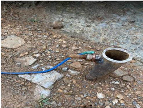
钻孔机设备接地线采用缠绕固定、未焊接固定
