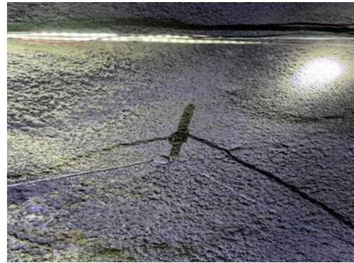
电缆线路直接架设在洞壁锚固钢筋端头
