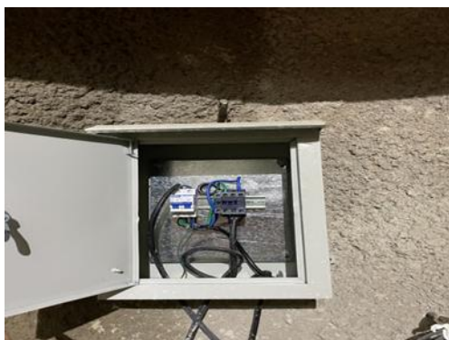
潜水泵开关箱内未设置漏电保护器，箱体未固定、未接地，箱门与箱体间无跨接接地线
