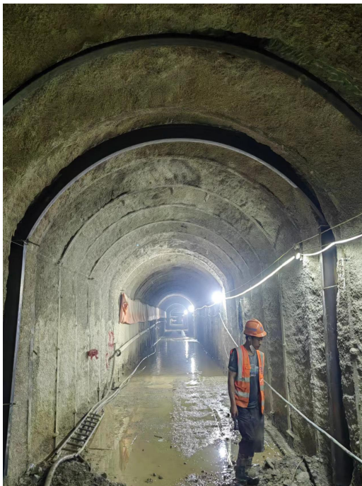
4#隧洞加装钢支撑
