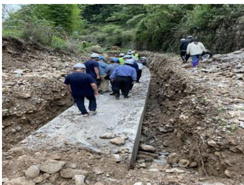
斜坡地段及沟槽未设置人员 上下通道
