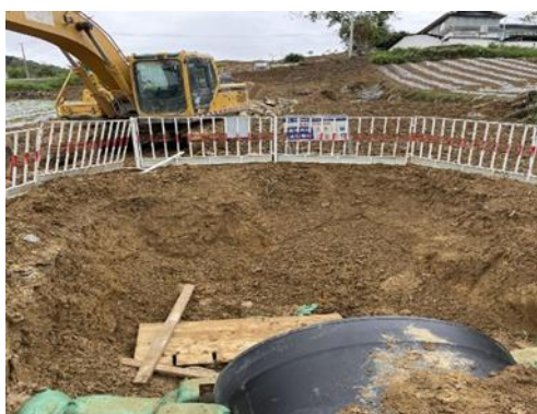
基坑放坡不够，局部边坡坍塌、土体开裂
