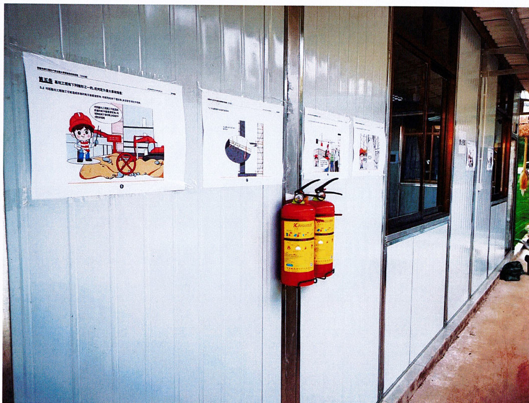
施工现场未粘贴重大事故判定宣传画册整改后
