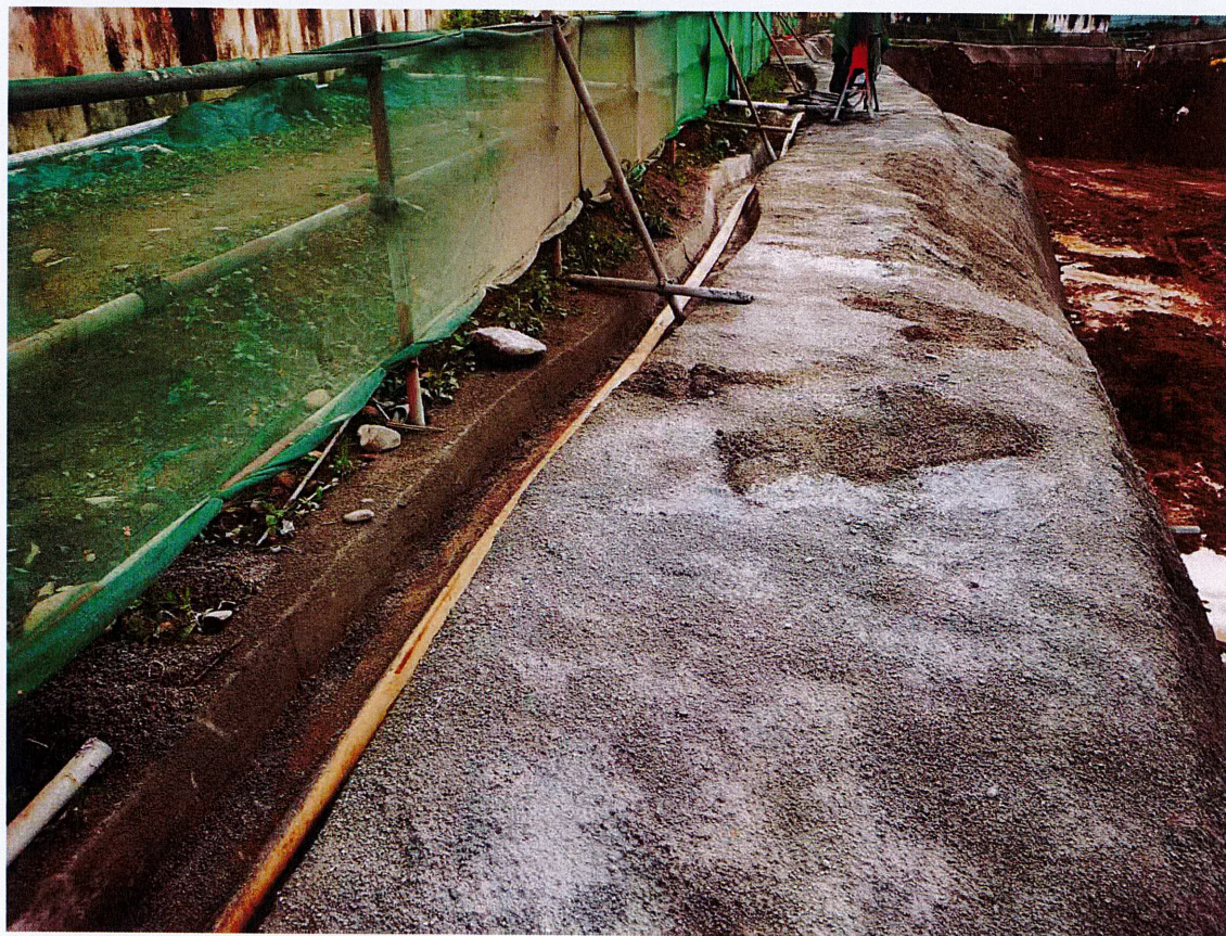
基坑顶部的排水沟整改后
