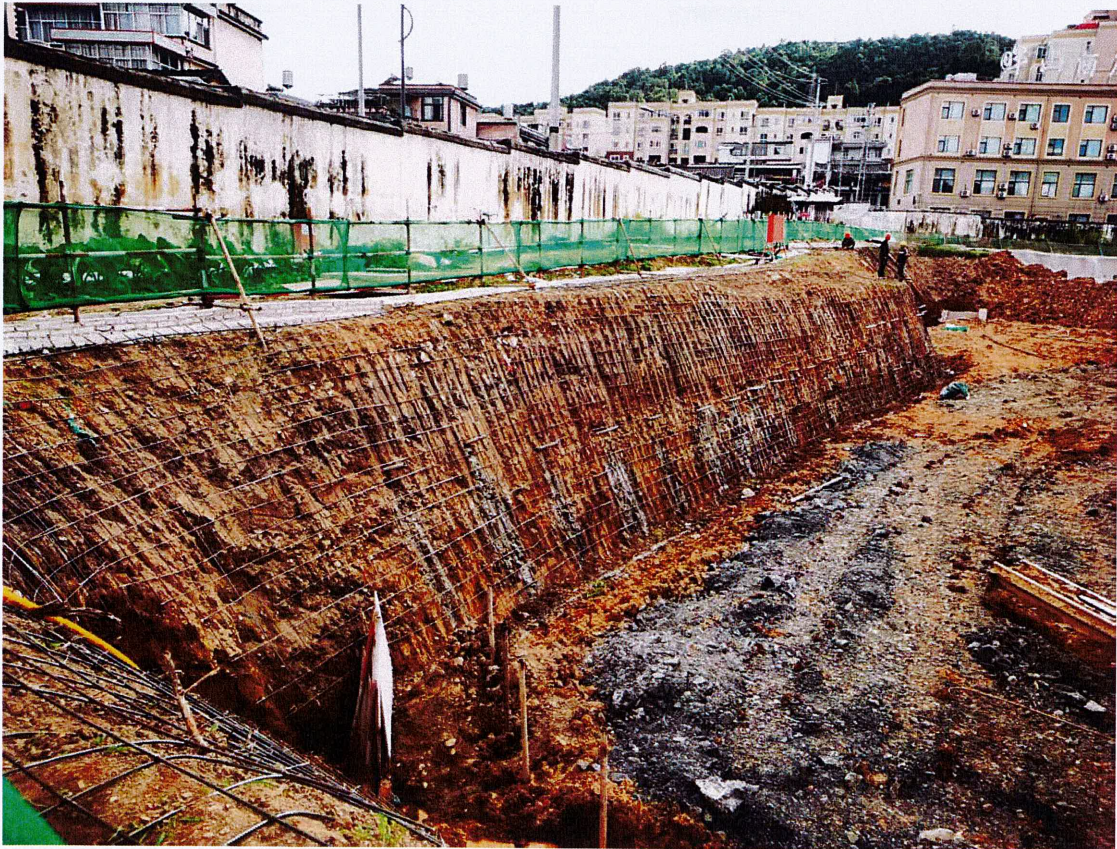
部分边坡放坡坡度不满足方案要求整改后
