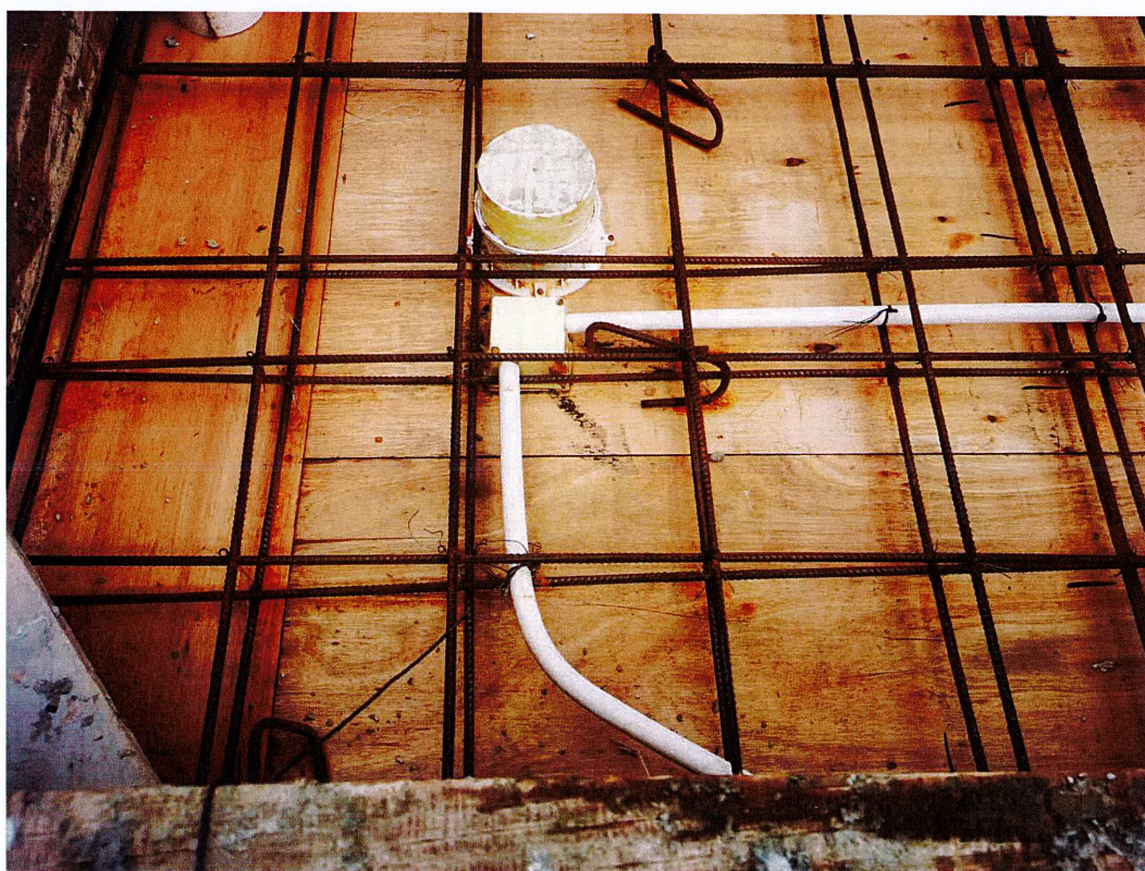
个别卫生间电线导管安装位置不符合规范要求整改后
