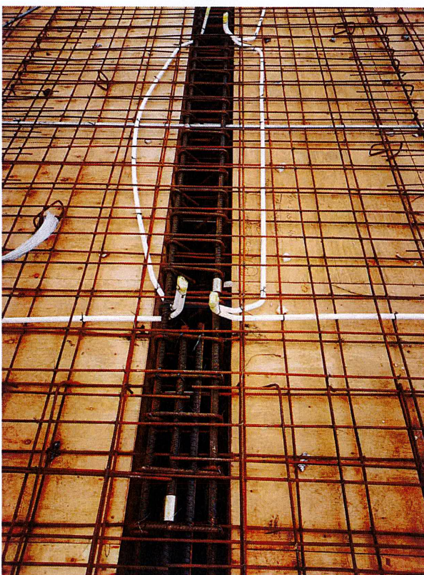
部分梁骨架偏移、位移整改后
