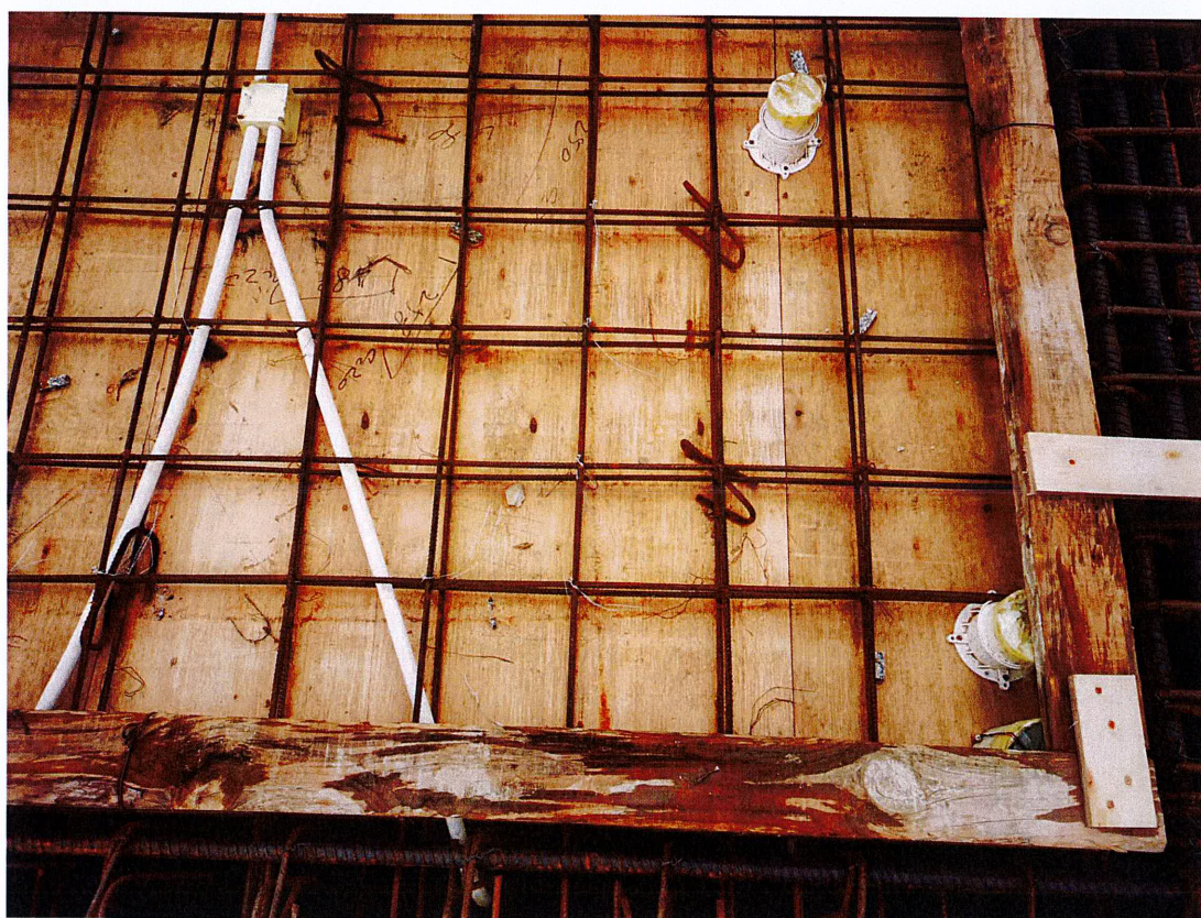
部分板底部钢筋网眼尺寸偏差较大整改后
