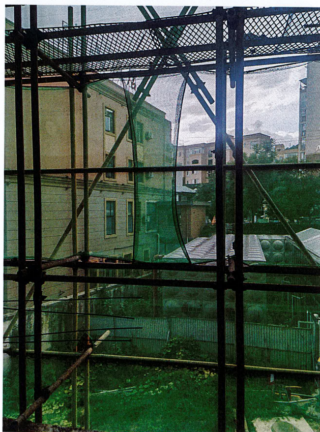
外脚手架违规堆放建筑材整改后
