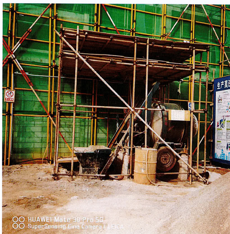
搅拌机防护棚架体搭设不符合安全要求整改后
