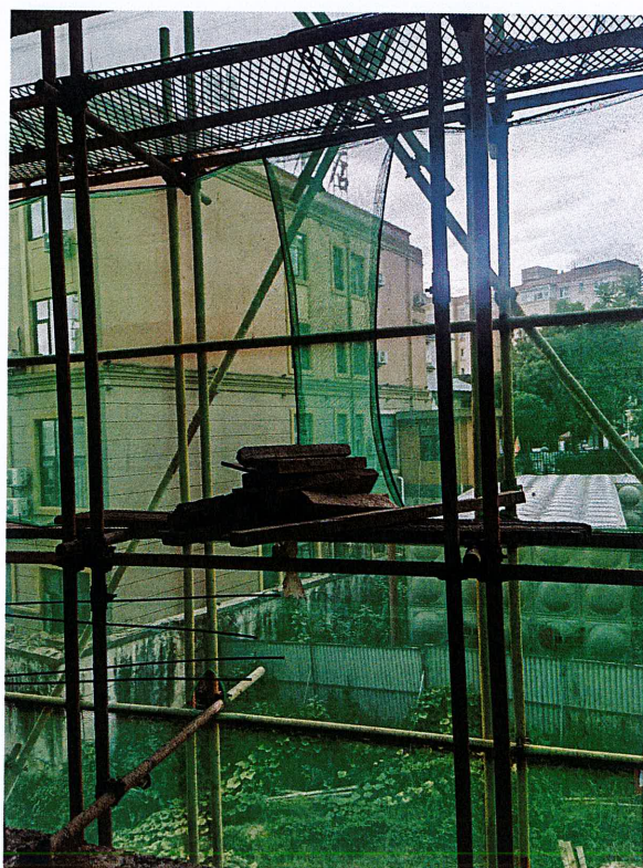
外脚手架违规堆放建筑材整改后
