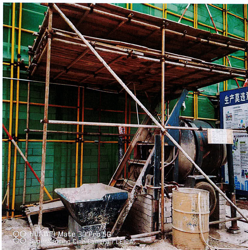
搅拌机防护棚架体搭设不符合安全要求整改后
