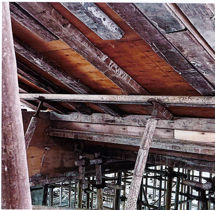
楼梯间支撑系统托撑偏移、未塞满整改后
