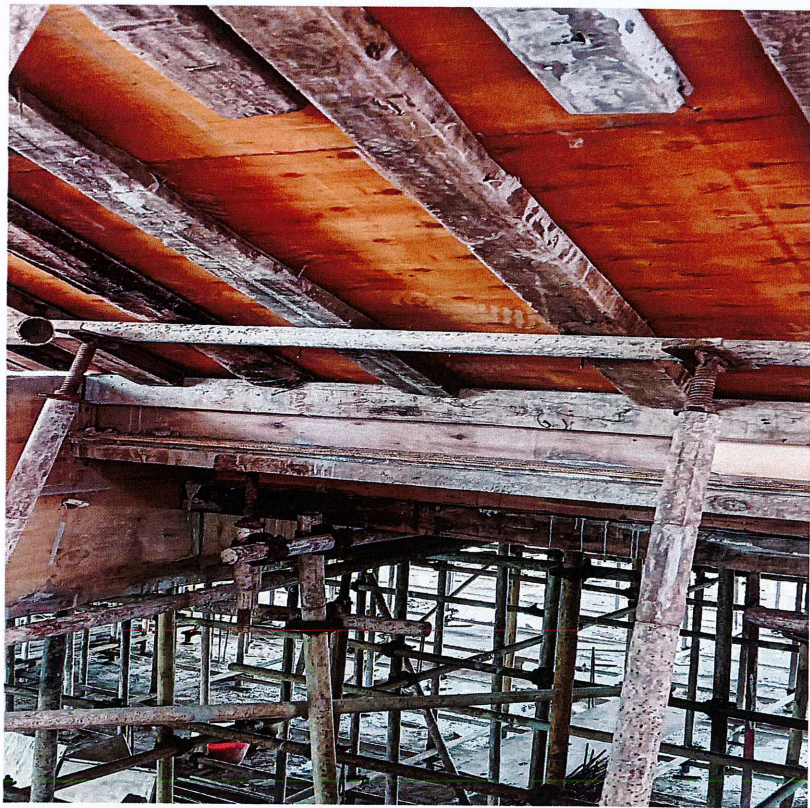
楼梯间支撑系统托撑偏移、未塞满整改后
