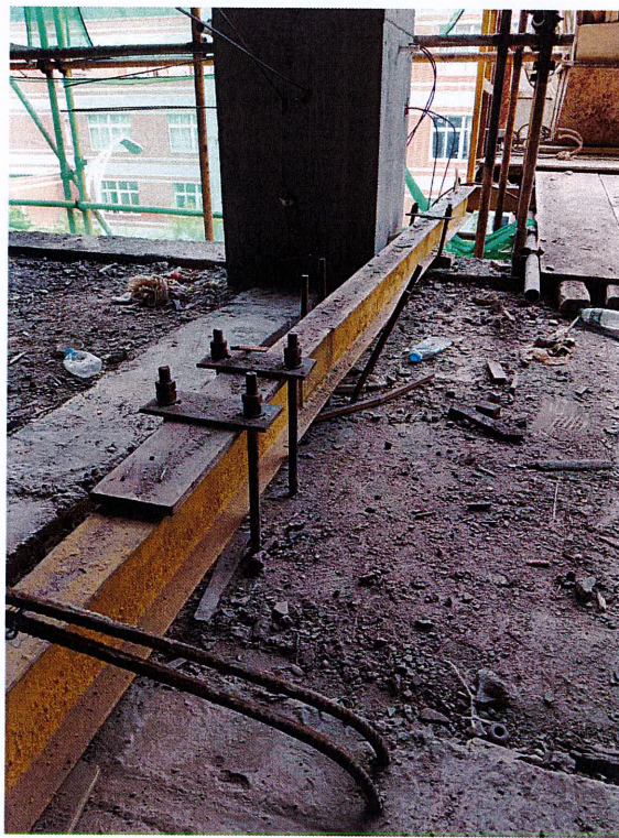
卸料平台工字钢两侧无垫块整改后
