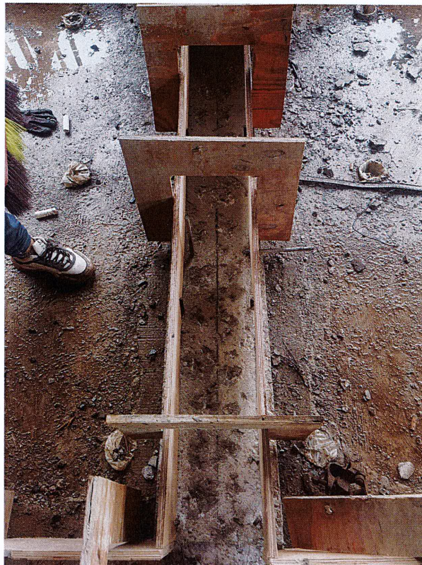
二楼卫生间四周混凝土翻边施工缝处理不符合要求整改后
