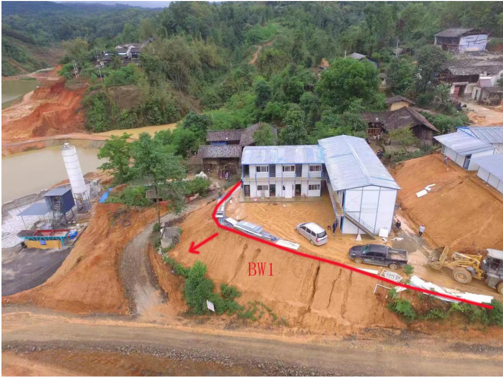
照片 4-1 BW1 不稳定边坡地貌形态
