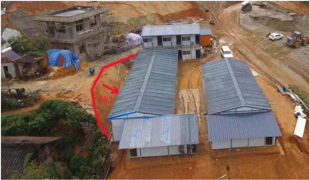
照片 4-3 BW3 不稳定边坡地貌形态
